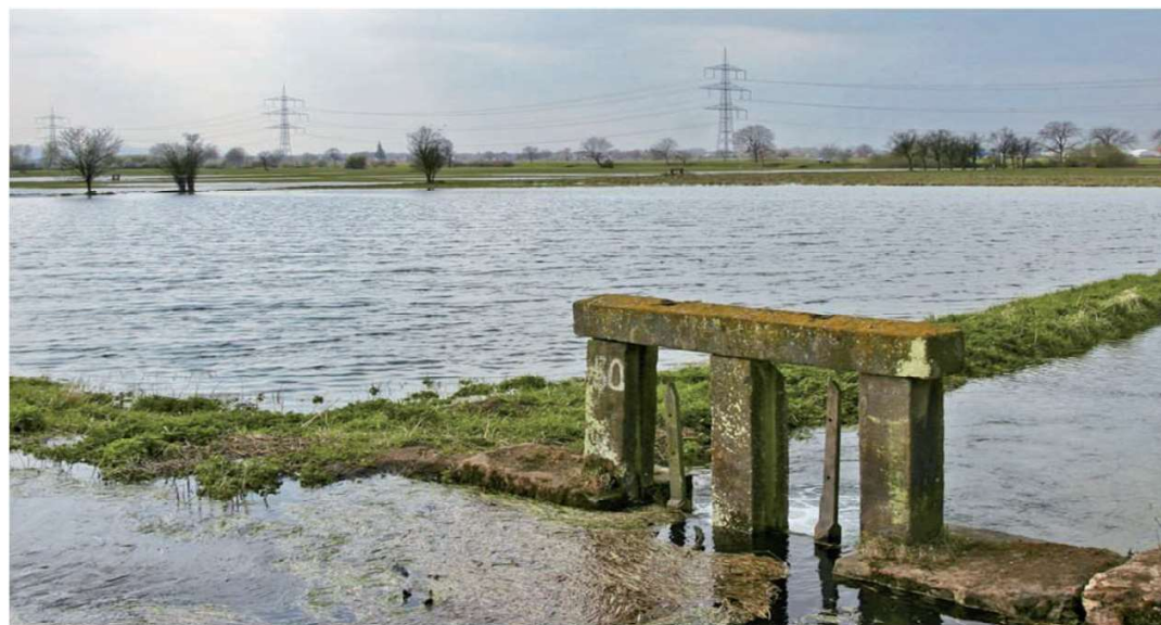
Par débordement du canal – terrain plat
