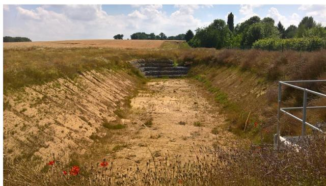
**Bassin de rétention en zone agricole. La zone de gradin est située au niveau de l'arrivée des eaux et permet d'éviter un risque d'effondrement des berges.**
