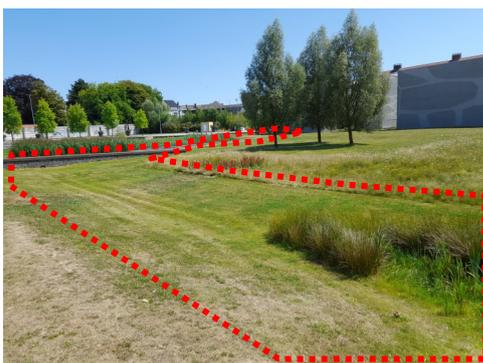
Le risque principal pour les noues est l'atterrissement. En effet, dans le cas où les eaux récoltées sont chargées en sédiments, le fond de la noue se colmate peu à peu, son volume de stockage diminue et elle ne peut plus se vidanger que ce soit par refus d'infiltration ou bouchage de l'ouvrage de fuite.
