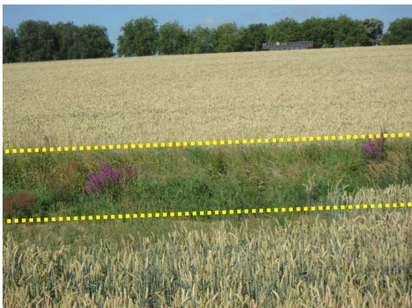
La végétation au sein du fossé exerce résistance et friction sur l'écoulement, réduisant la vitesse et augmentant la hauteur d'eau et le temps de rétention hydraulique. Ce temps de rétention peut encore être augmenté par la mise en place de redents.
