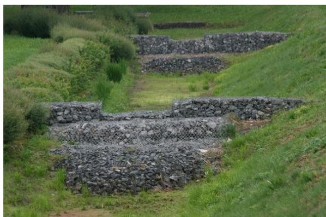
**Fossé à redents** : recoupé de cloisons transversales (en terre, gabions ou béton) munies d'un point de fuite à leur base autorisant une évacuation lente des eaux. Les compartiments successifs se déversent les uns dans les autres. Une partie de l'eau peut s'y accumuler et éventuellement s'y infiltrer. Le fossé à redents permet de temporiser les eaux de ruissellement afin de soulager les ouvrages d'évacuation situés à l'aval.
