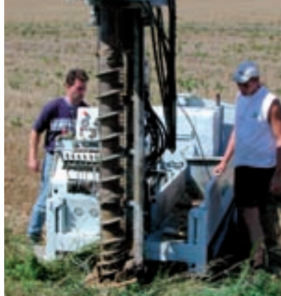
Dans le bassin pilote d'Arquennes, plusieurs petits puits appelés piézomètres ont été forés pour délimiter la zone d'alimentation.
