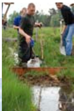
Drainageverstopfungen zwecks Wiederherstellung von Feuchtgebieten
