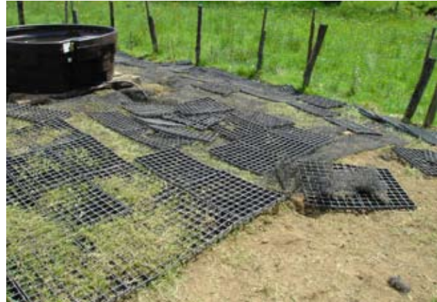
Figures 48 à 50 : Déplacement des dalles de stabilisation et embourbement suite au piétinement du bétail (absence d'assise sous-jacente plane)
