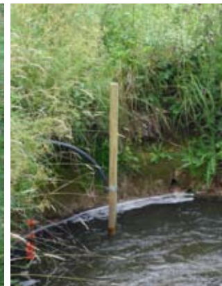
Stabilisation verticale de la crépine avec clapet anti-retour
