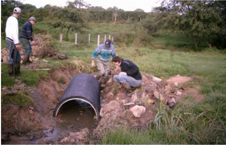
Figure 64 : Placement d'un demi tube en PEHD
