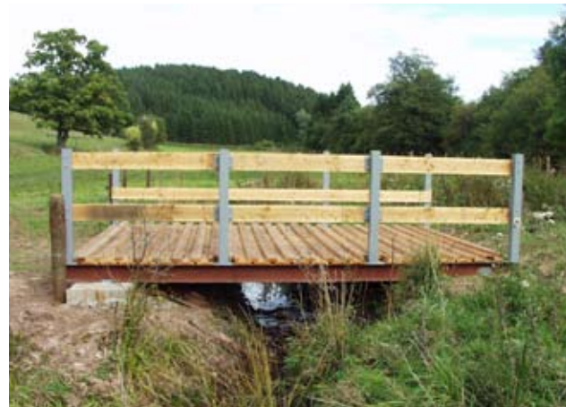
Figure 58 : Passage en bois pour bétail et engins agricoles avec poutrelles métalliques et fondations en béton
