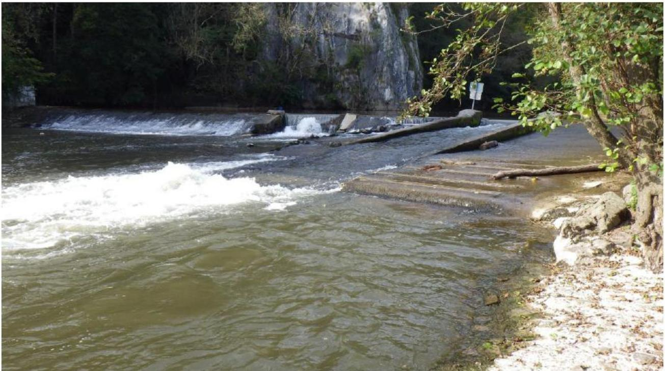
**Photo :** barrage de Pont à Lesse avec passe à kayak (dH= 1.20mètres)
