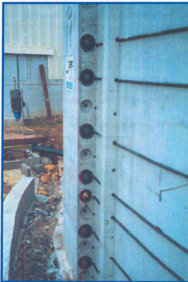
Figure 25 : parois en éléments préfabriqués pour fosse
